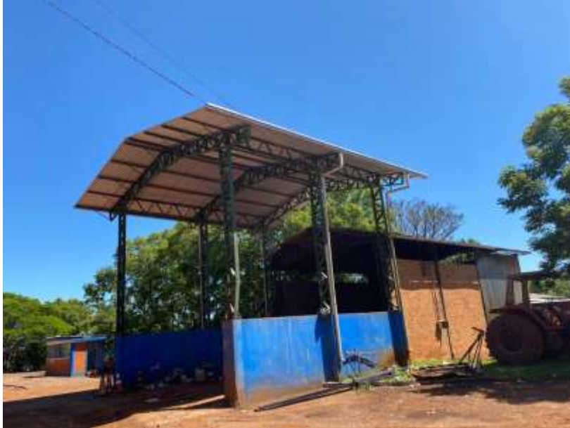
Figura 12 - Pavilhão de recebimento resíduos orgânicos.
